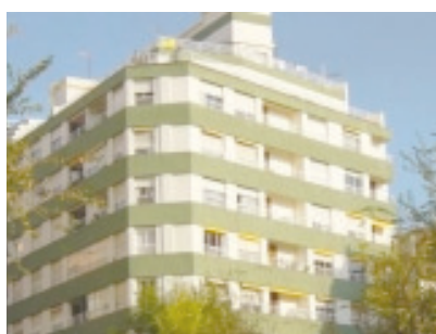
Edificio Pau Casals Tarragona
